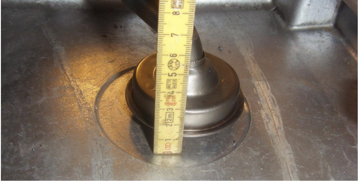
Vue de la crépine après modification
